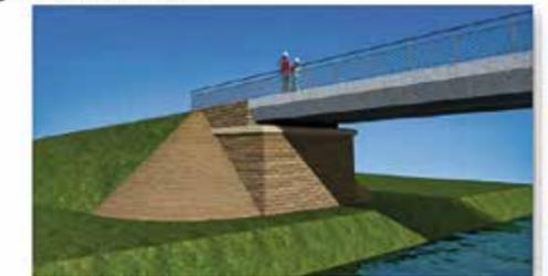
Aménagement des têtes de pile et confortement des enrochements en pied de piles dans le Cher
