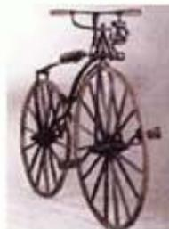
La silhouette du « Michaux » à deux roues de même diamètre fût rapidement déformée. Déjà, on recherchait à améliorer la vitesse. Etant donné la conception de l'engin en service jusqu'alors, l'objectif fût d'augmenter le diamètre de la roue avant motrice. Par contre, le rôle de la roue arrière se limitant à assurer la stabilité, la
