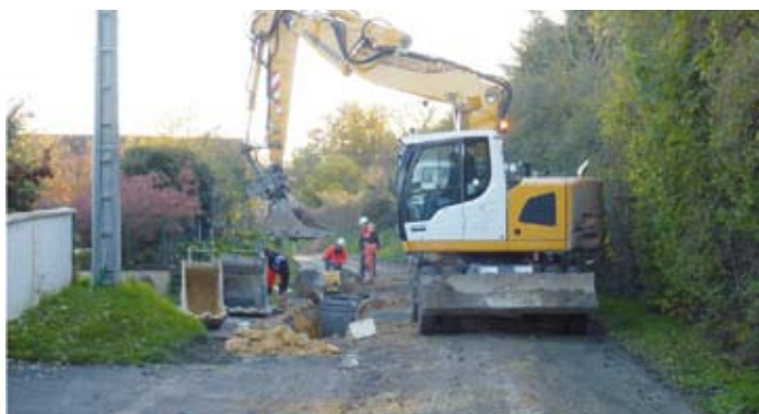
Travaux d'assainissement rue de Beauregard
