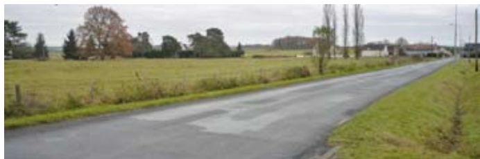
Vue du côté ouest
