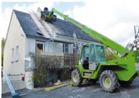
Réparation de la toiture de la garderie
