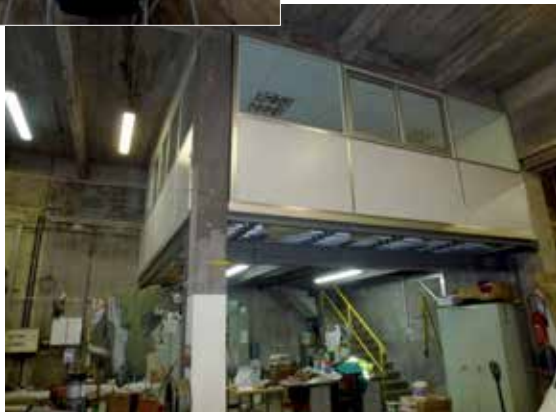
Aménagement plateforme-bureau au local technique du chai
